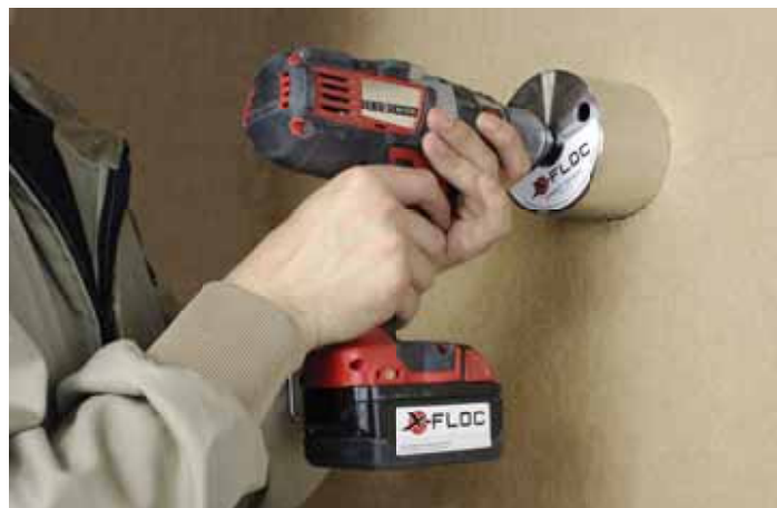
Hulsav HF til præcise indblæsningshuller i bløde træfiberplader.
