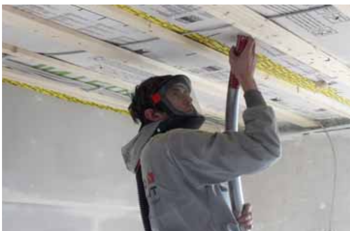
Indblæsningsnål med en specielt formet, farvekodet spids som placeringhjælp.
