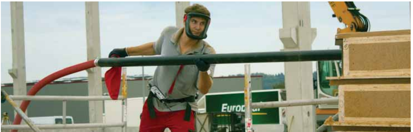
Professionel fyldning af element ved hjælp af ventileret, udluftet indblæsningslans
