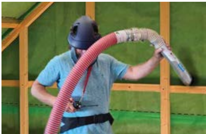
Drejelige slangeforbindelser (SDV) gør det lettere at arbejde med indblæsningsnålen
