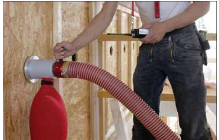
Komprimeret indblæsning med udluftning
