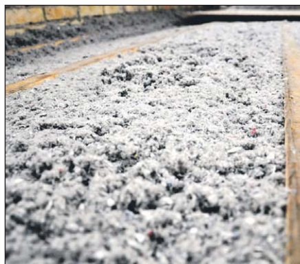
En af de mere opsigtsvækkende konklusioner er, at der ikke fandtes tegn på fugt eller kondens selv på lofter, hvor der ikke er brugt dampspærre.
