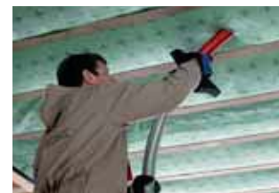
Isolator med indblæsningsnål ved loftisolering
